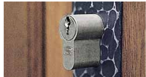
Gefährlich: ein vorstehender Schließzylinder.
